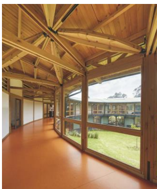
Imagem 17 – Estrutura de madeira e metal
